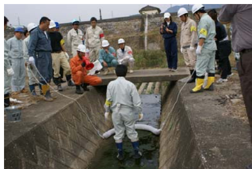
水路内での吸着フェンス設置
