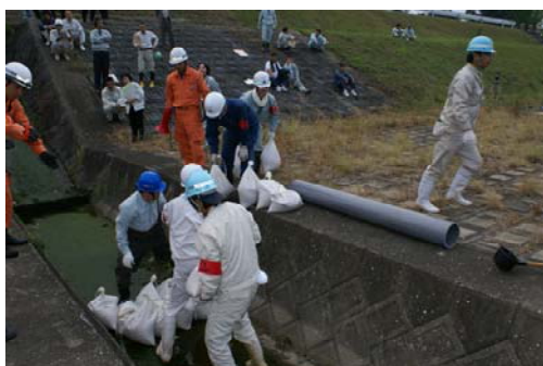
水路内での土嚢積み
