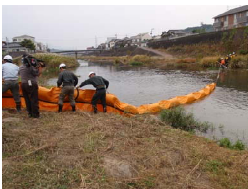
オイルフェンス展張作業
