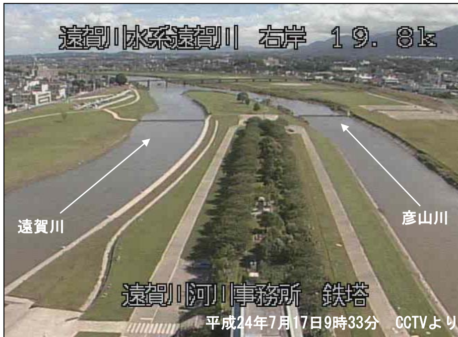
通常時：事務所（本川19k8付近）より下流を望む
