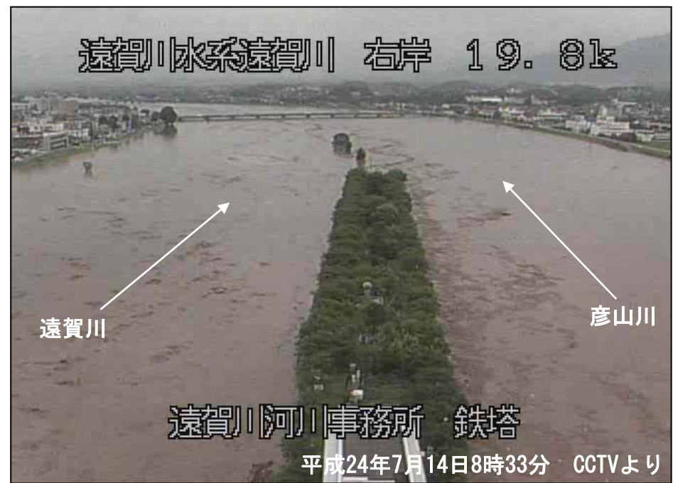
出水ピーク時：事務所（本川19k8付近）より下流を望む
