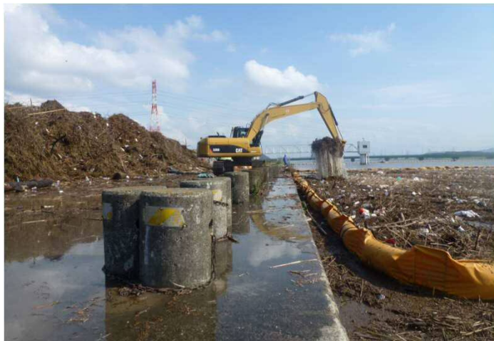
ゴミの撤去作業(陸揚げ)状況(7月14日撮影)
