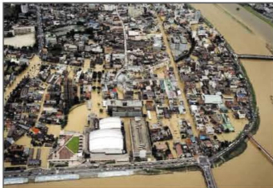
平成15年7月豪雨による被害状況
