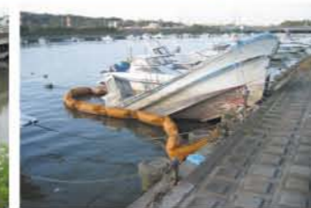
乗り上げによる護岸の損傷
