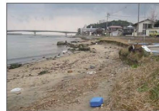
芦屋河岸の侵食状況
