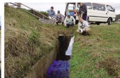
水質浄化用の炭設置
