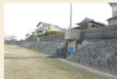
現在のパラペット堤防
