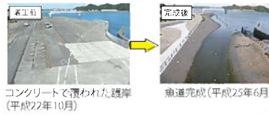
コンクリートで覆われた護岸 魚道完成(平成25年6月)
