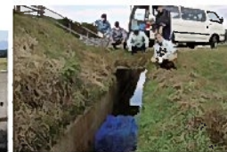
水質浄化用の炭設置
