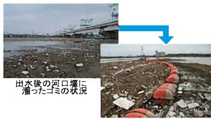
新たに設置したゴミを捕捉する施設(網場)完成25年7月
