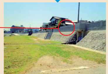
補修後のパラペット堤防
