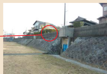
補修前のパラペット堤防
