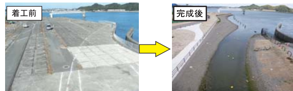
着工前 コンクリートで覆われた護岸 (平成22年10月)
