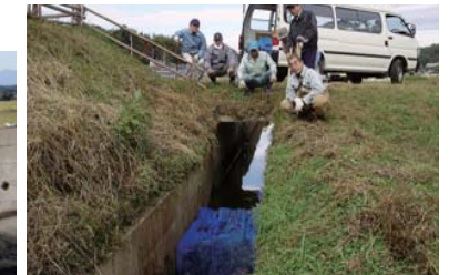
水質浄化用の炭設置
