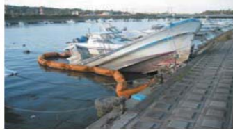
乗り上げによる護岸の損傷
