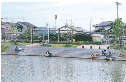
河川改修後の状況
