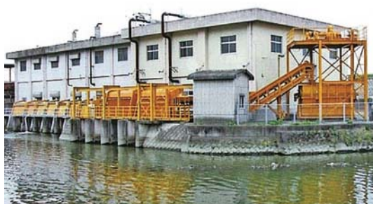
曲川の机排水機場
