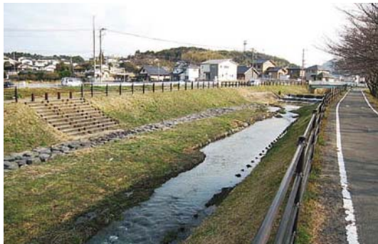
正矢口橋付近から上流を望む（汐入川）
