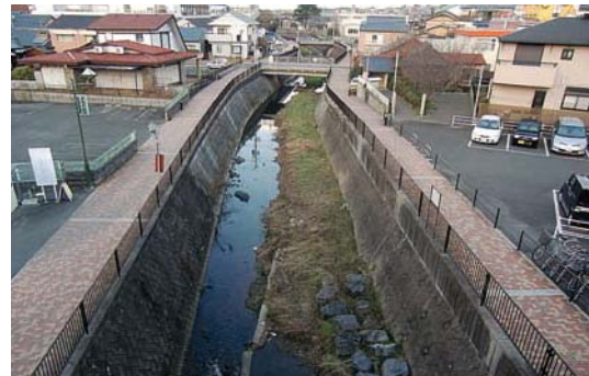
駅前広場近くの河川整備状況（矢矧川）
