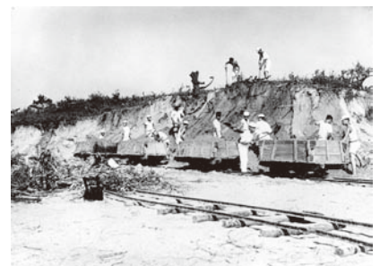
飛行場の建設工事 (芦屋町制百周年記念誌より)
