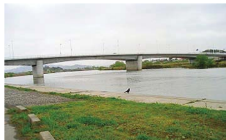
遠賀橋の架替後
