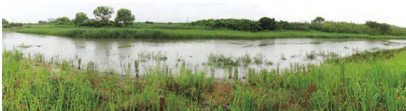
掘削後の状況
