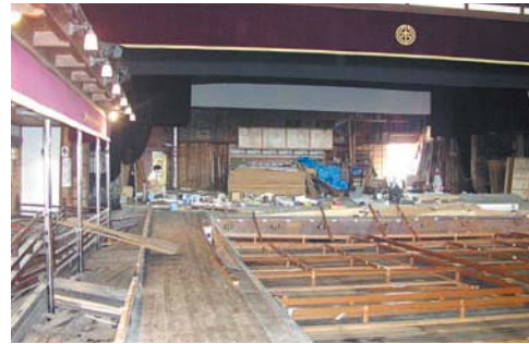
平成15年出水：被災した嘉穂劇場
