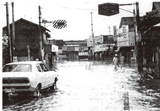
昭和55年出水：飯塚市鯉田地区浸水状況
