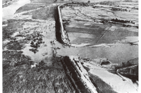
決壊した堤防（遠賀川14/000左岸）直方市植木付近
