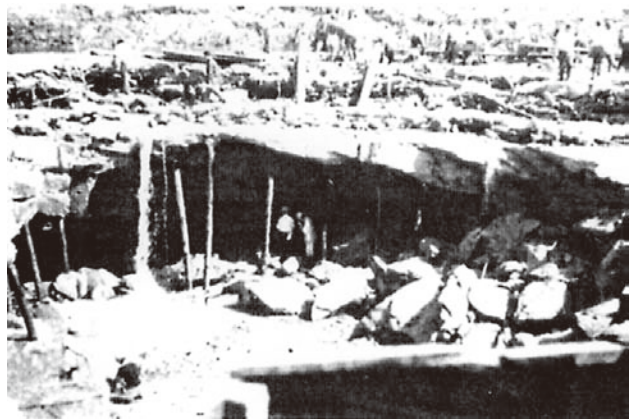
昭和35年9月20日 中元寺川河床陥没現場
