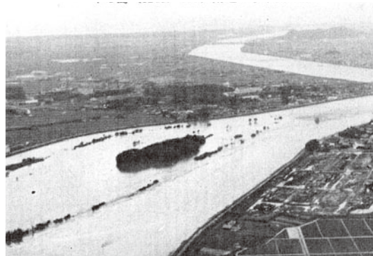
昭和55年出水：中の島付近より下流を望む
