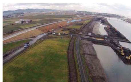
築堤および河道拡幅
