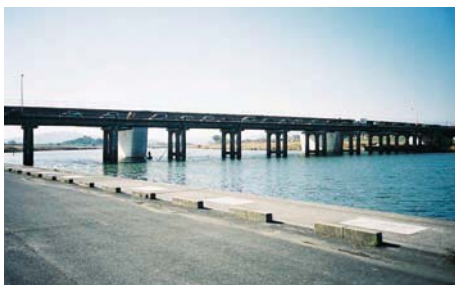
遠賀橋の架替前
