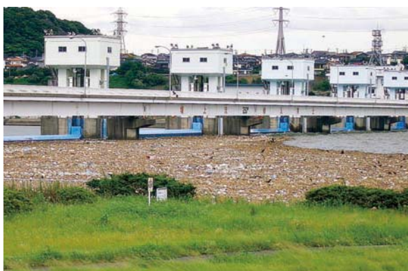
遠賀川河口堰に流れついた大量のゴミ
