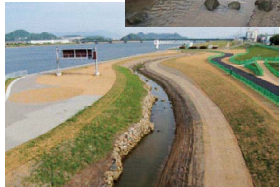
工事完成状況（2012.6）
