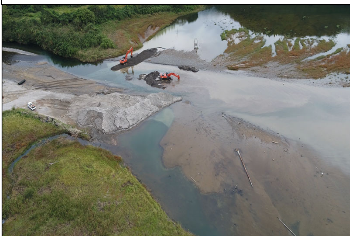
堆砂除去工事中（令和4年10月13日時点）
