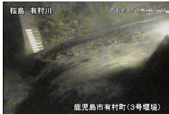
有村川 3号堰堤
