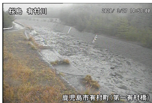
有村川土石流の様子(3月27日)
