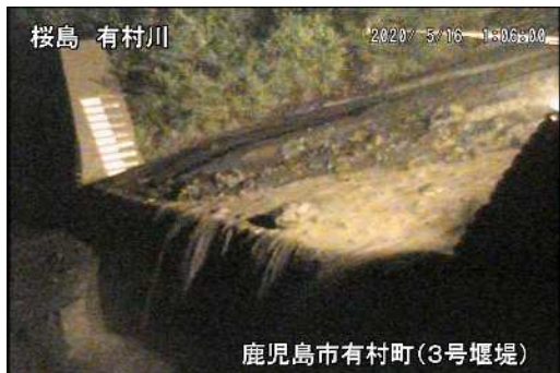
有村川土石流の様子(5月16日)
