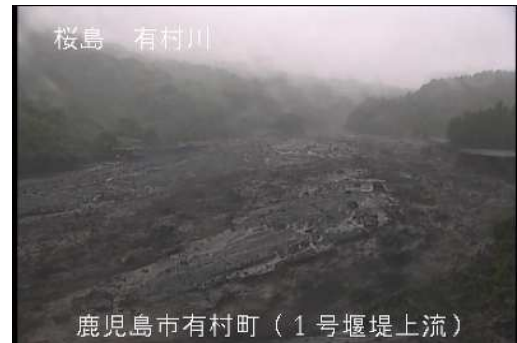
有村川土石流の様子(6月11日)
