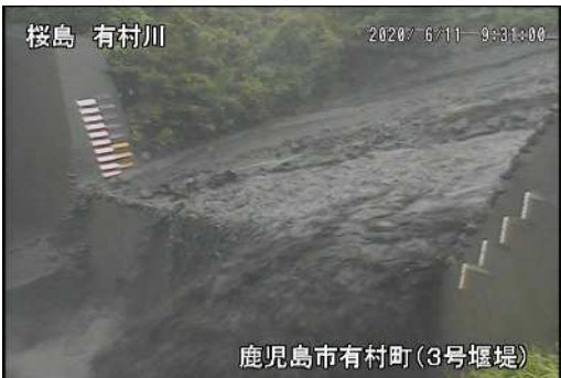
有村川土石流の様子(6月11日)
