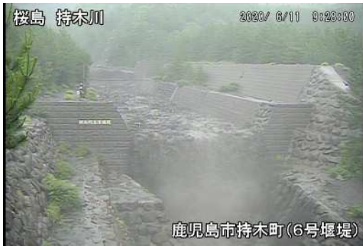
持木川土石流の様子(6月11日)
