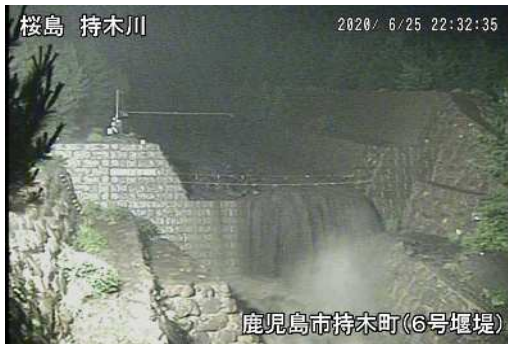
持木川土石流の様子(6月25日)
