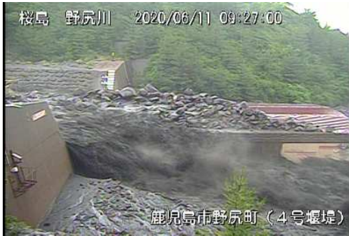
野尻川土石流の様子(6月11日)
