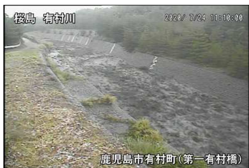
有村川土石流の様子(7月24日)
