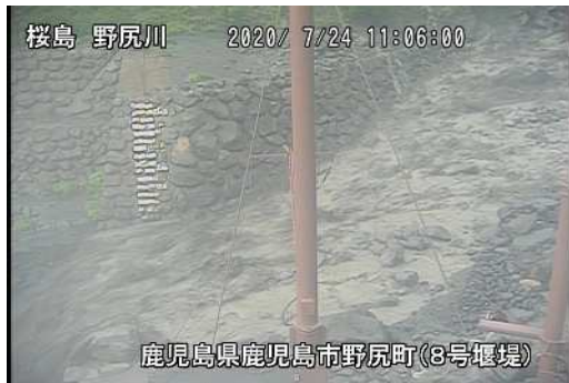
野尻川土石流の様子(7月24日)
