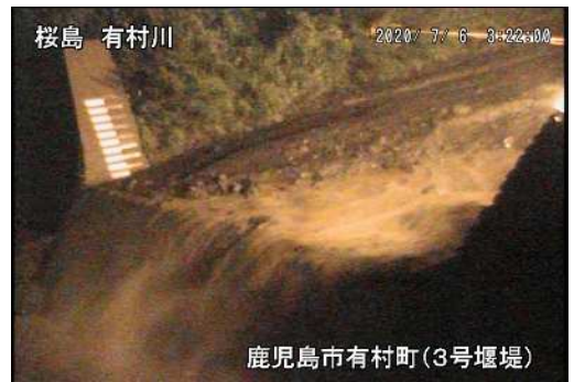
有村川土石流の様子(7月6日)
