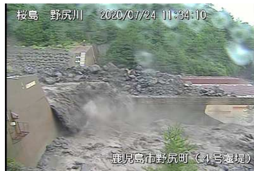
野尻川土石流の様子(7月24日)
