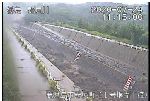
野尻川土石流の様子(7月24日)
