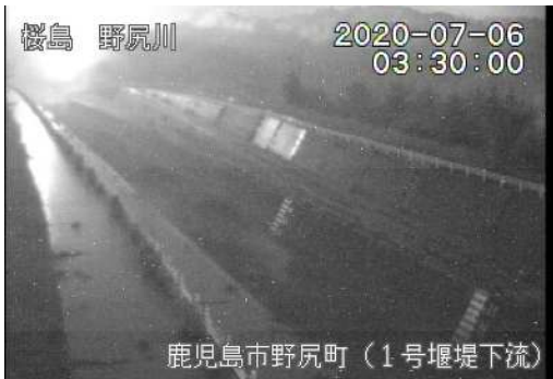
野尻川土石流の様子(7月6日)
