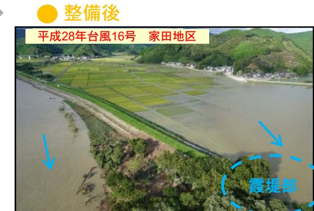
霞堤からの流水により浸水しているが宅地嵩上げにより家屋浸水は大幅に低減!
