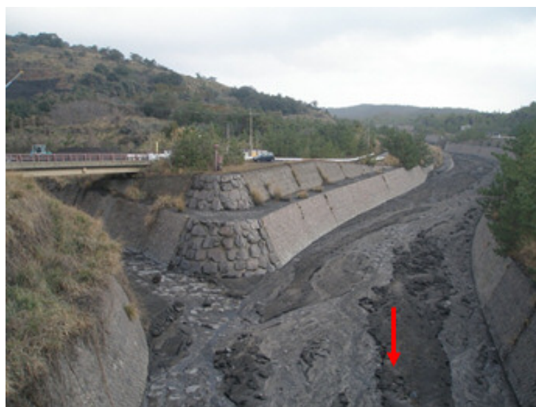
写真② 第一有村橋から上流を望む（H27. 2. 23 9時30分撮影）
