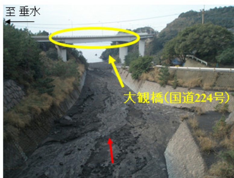
写真① 第一有村橋から下流を望む（H27. 2. 23 9時30分撮影）
