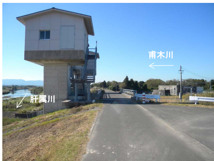
甫木水門の堤防道路状況
