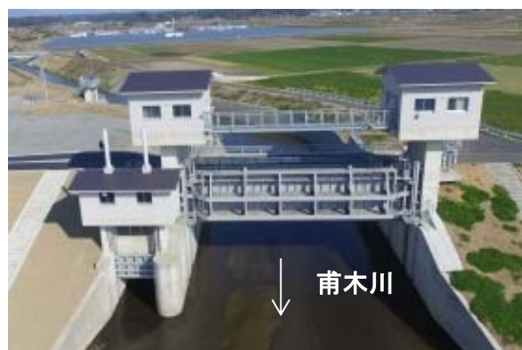
○甫木水門の平常時操作状況
