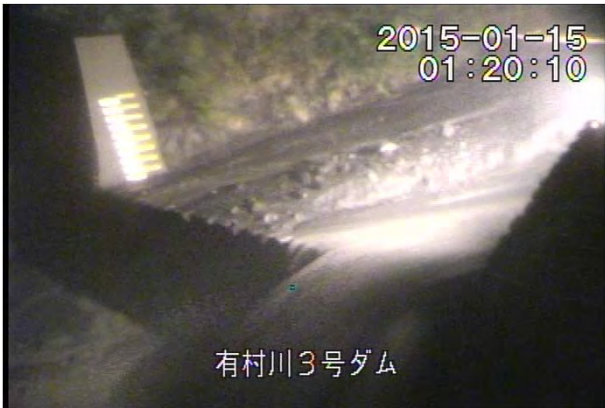
有村川 土石流の様子(1月15日)
