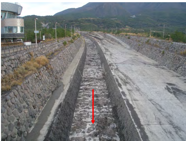
写真② 野尻橋から上流を望む（H26. 1. 9 9時30分撮影）
