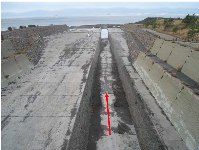
写真① 野尻橋から下流を望む（H26. 1. 9 9時30分撮影）
