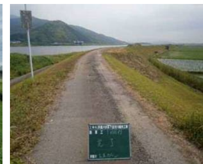
堤防点検（1回／年）
