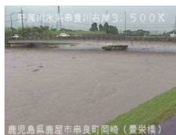
令和2年7月6日 10時頃の状況 (串良川 豊栄橋)
