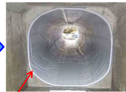
老朽化した図体の修繕
