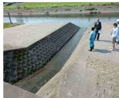
樋管の巡視（1回／年）
