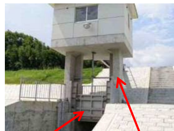
ゲートのステンレス化 老朽化した樋管の更新
