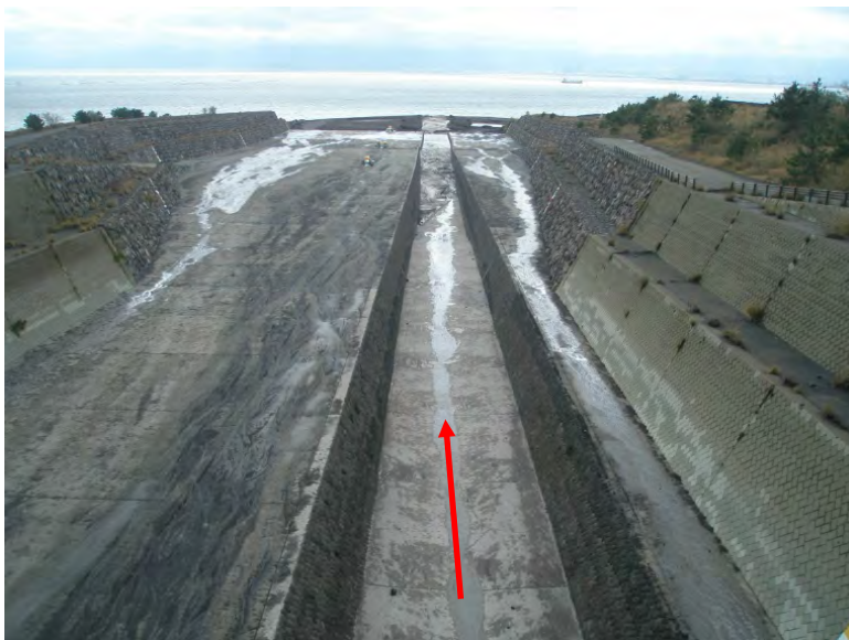
写真① 野尻橋から下流を望む (H26. 3. 13 13時30分撮影)
