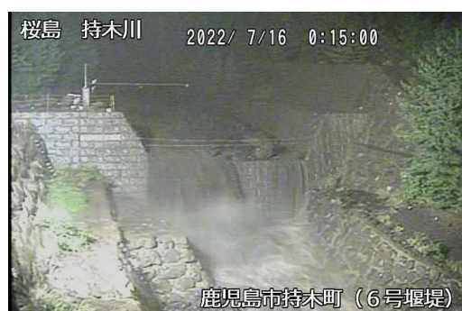
持木川土石流の様子(7月16日)
