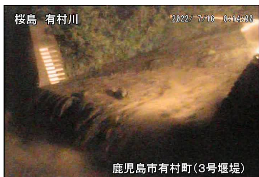
有村川土石流の様子(7月16日)
