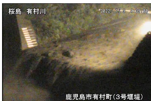
有村川土石流の様子(7月9日)
