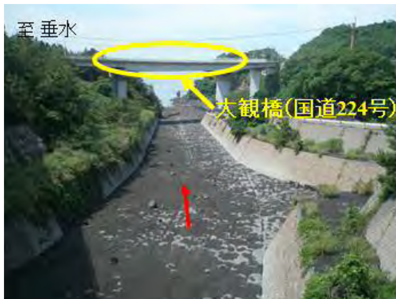
写真③ 第一有村川橋から下流を望む（H26. 5. 13 11時00分撮影）
