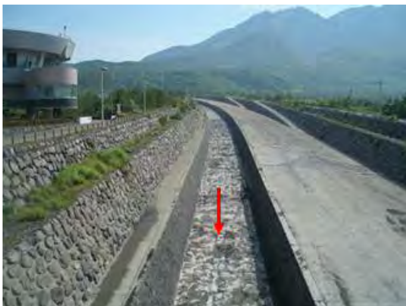
※顕著な土砂堆積は見られない。
