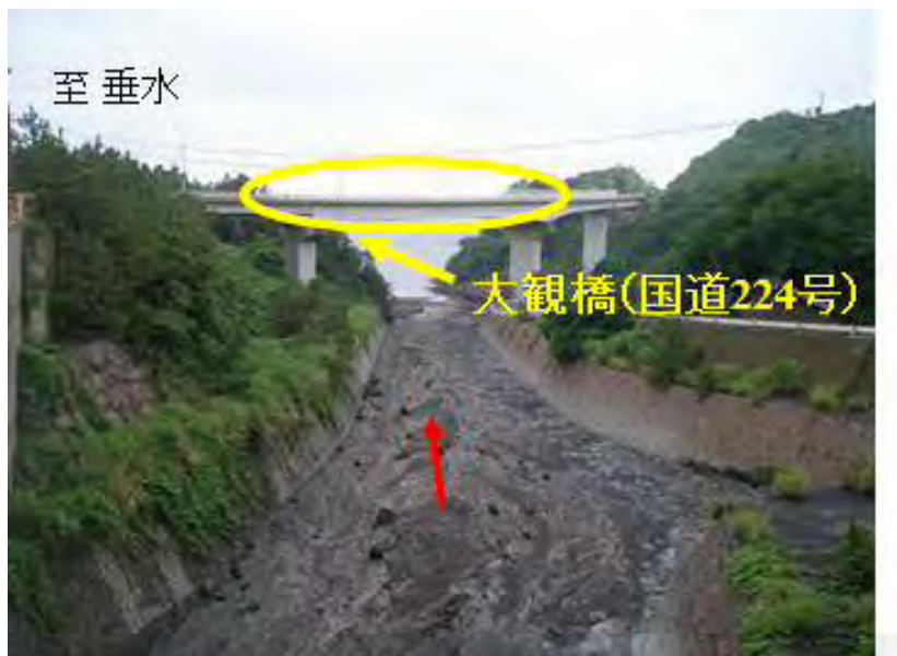
写真③ 第一有村川橋から下流を望む（H26. 5. 15 9時50分撮影）
