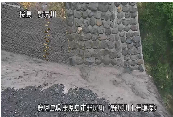
野尻川土石流の様子(3月9日)
