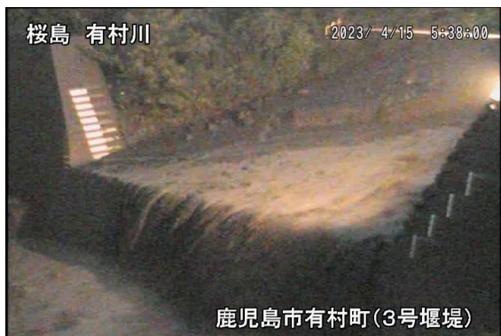
有村川土石流の様子(4月15日)
