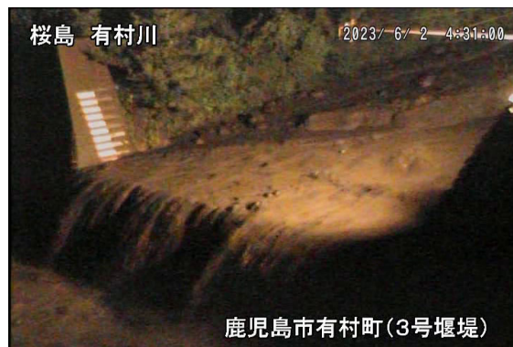
有村川土石流の様子(6月2日)
