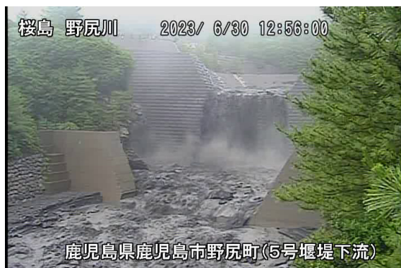
野尻川土石流の様子(6月30日)
