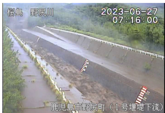
野尻川土石流の様子(6月27日)
