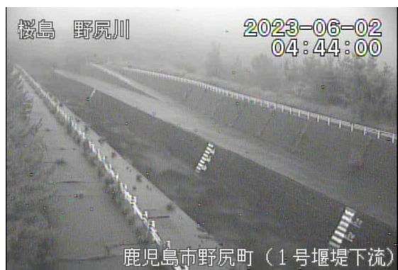
野尻川土石流の様子(6月2日)
