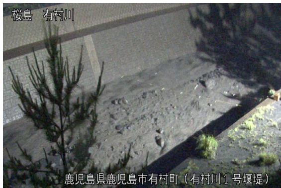
有村川土石流の様子(6月2日)
