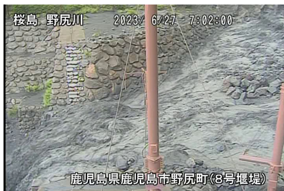
野尻川土石流の様子(6月27日)
