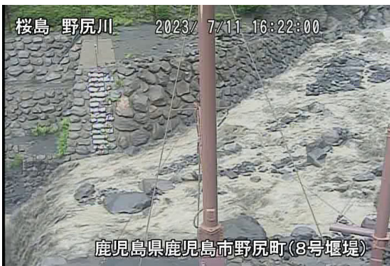
野尻川土石流の様子(7月11日)
