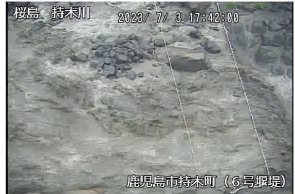
持木川土石流の様子(7月3日)
