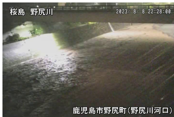
野尻川土石流の様子(8月8日)
