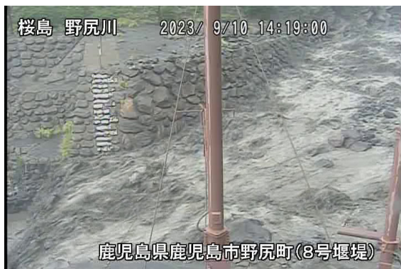
野尻川土石流の様子(9月10日)
