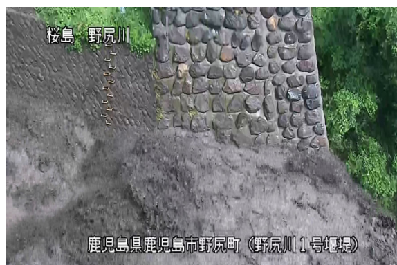
野尻川土石流の様子(9月10日)
