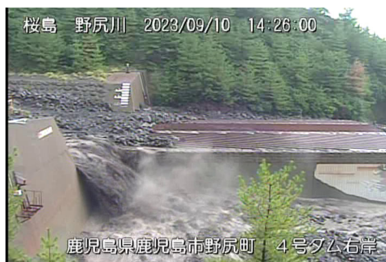
野尻川土石流の様子(9月10日)
