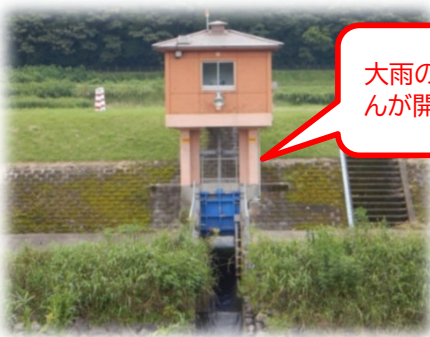
工事前の川東第4樋管
