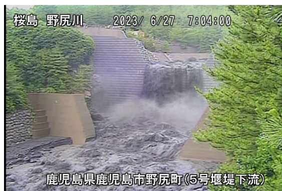
野尻川土石流の様子(6月27日)
