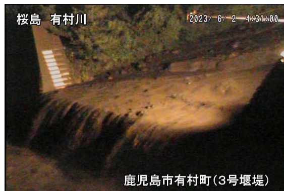
有村川土石流の様子(6月2日)
