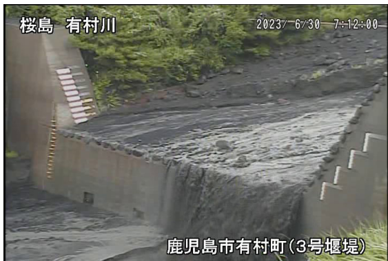
有村川土石流の様子(6月30日)
