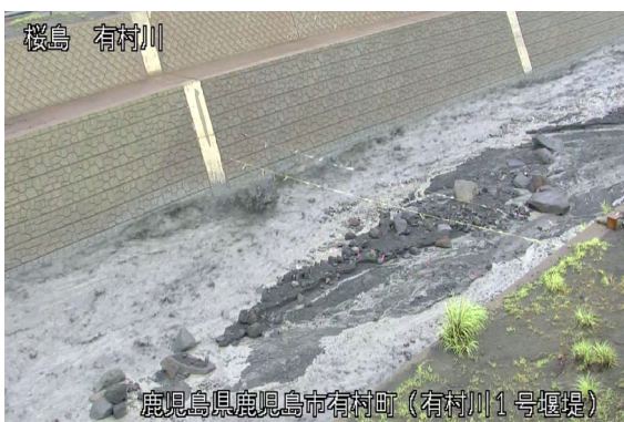
有村川土石流の様子(6月30日)
