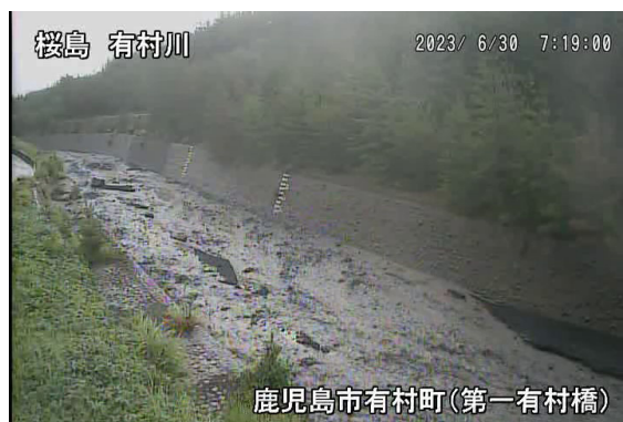
有村川土石流の様子(6月30日)
