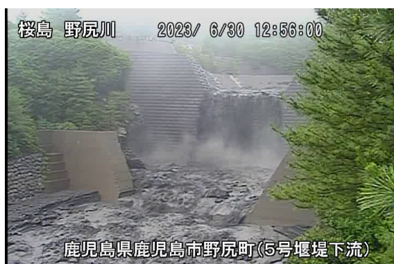
野尻川土石流の様子(6月30日)
