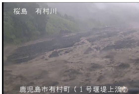
有村川土石流の様子(8月9日)
