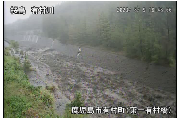
有村川土石流の様子(8月9日)
