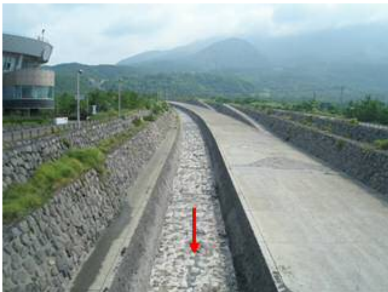
※顕著な土砂堆積は見られない。
