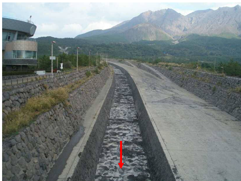
※顕著な土砂堆積は見られない。
