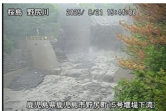
野尻川土石流の様子(8月21日)
