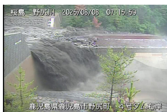
野尻川土石流の様子(8月8日)
