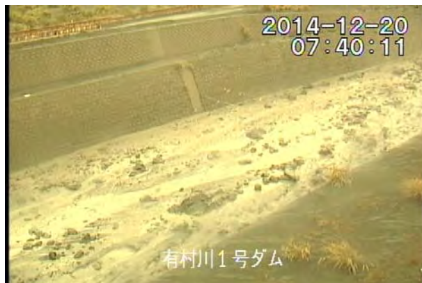
有村川 土石流の様子(12月20日)
