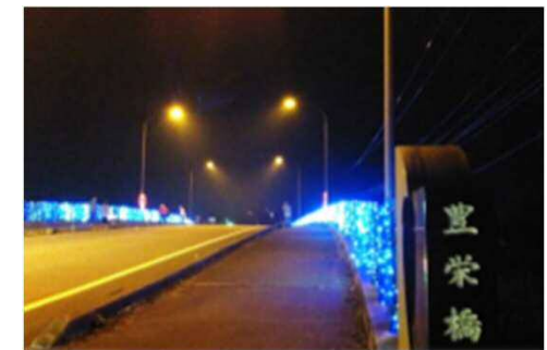
豊栄橋イルミネーション（支川串良川）
