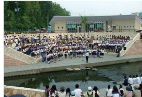
肝属川水辺プラザ（肝属川上流部）
