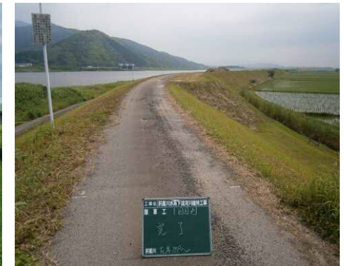
堤防点検（1回／年）
