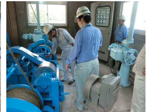
管理施設の点検（1～2回／月）
