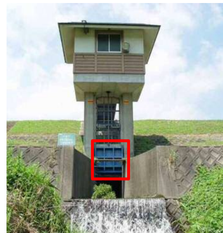
ゲートの無動力化（フラップゲート化）
