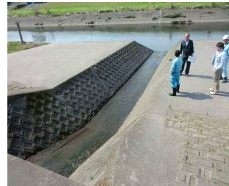
樋管の巡視（1回／年）
