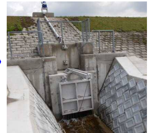
ゲートの無動力化（フラップゲート化）
