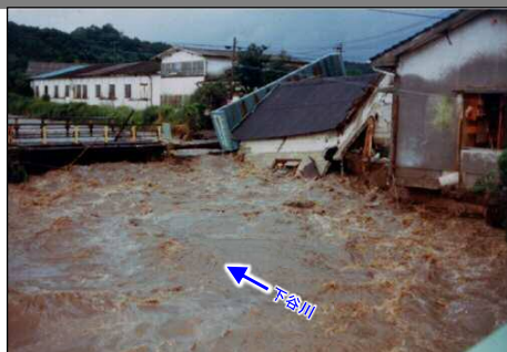
鹿屋市内(下谷川0.2k付近右岸) 浸水状況
