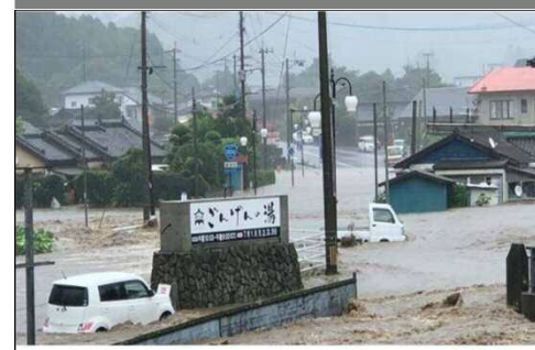
鹿屋市内(肝属川23.7k付近右岸) 浸水状況
