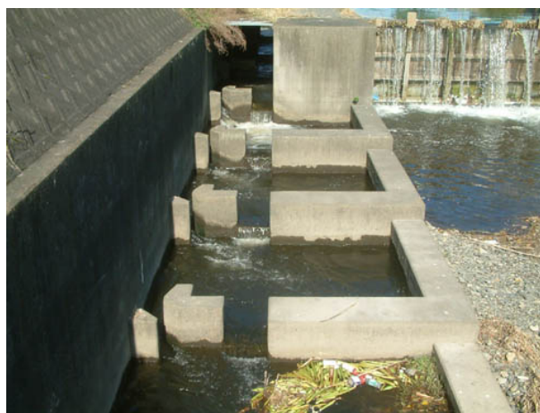
写真 4.2.4 魚道の整備事例（新和田井堰：肝属川本川）
