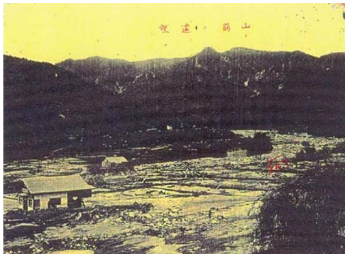
写真 1.2.2 肝付町後田方野付近被害状況
