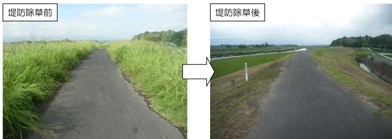
写真 4.3.3 堤防除草の実施前・後
