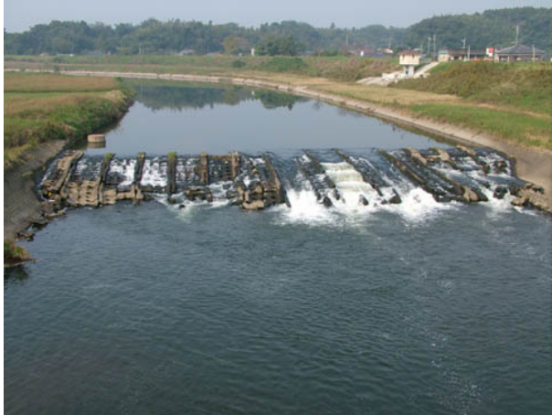
写真 2.1.8 床止め (宮下床止：肝属川本川)
