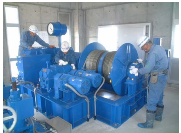
写真 4.3.5 水門（巻上機）の保守点検
