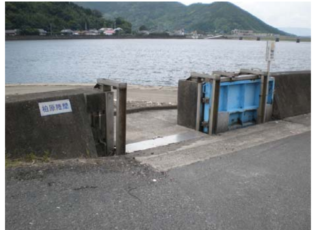
写真 2.1.11 陸閘門 (柏原陸閘：肝属川本川)
