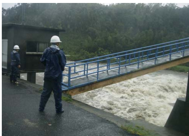
写真 2.1.12 洪水時の巡視状況
