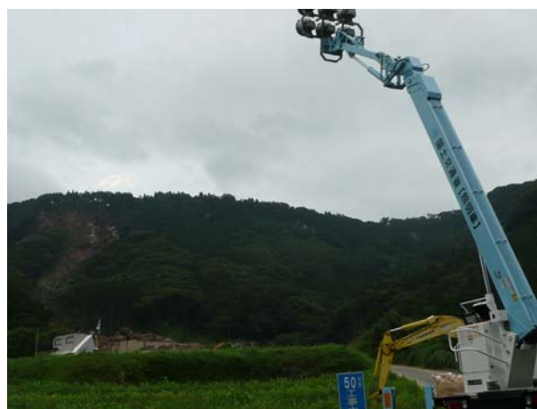
写真 4.3.18 夜間監視用の照明車
