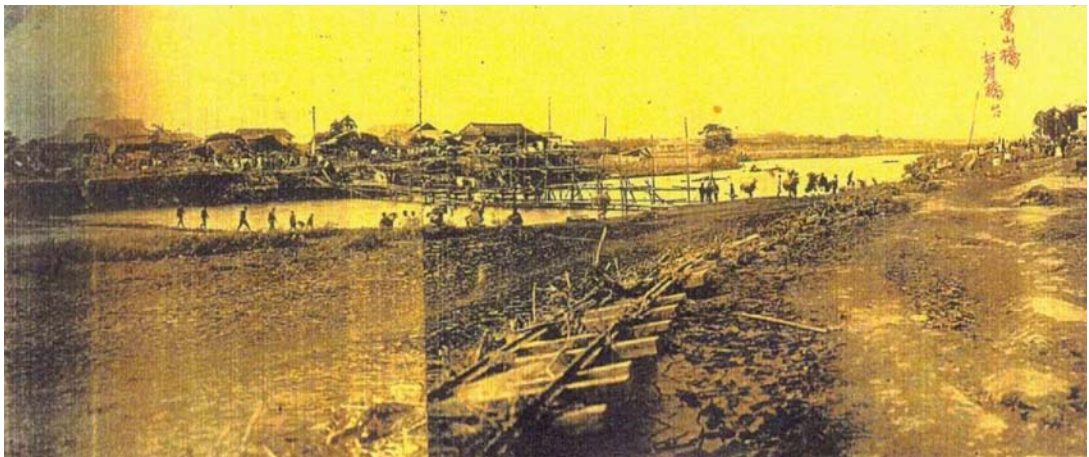
写真 1.2.1 高山川 2/300 付近（高山橋）被害状況
