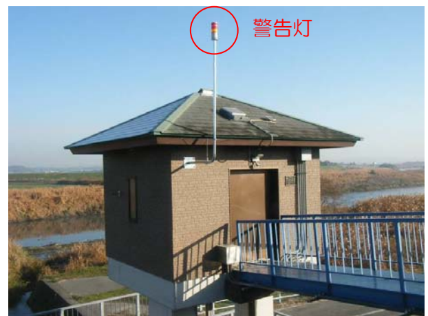
写真 4.3.13 樋管の警告灯
