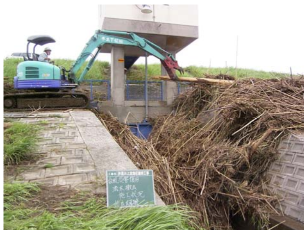
写真 4.3.6 流木、塵芥の除去
