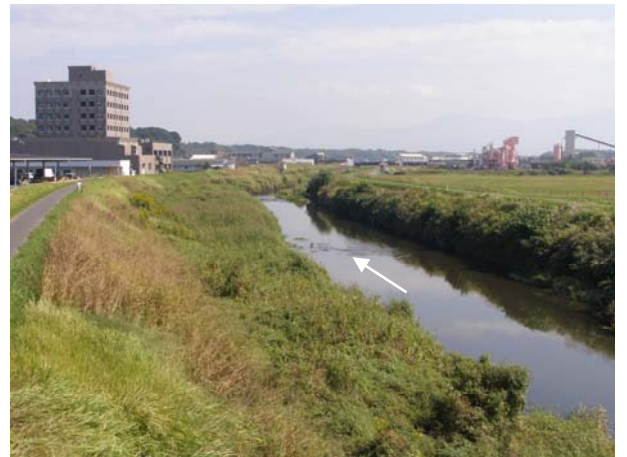
写真 2.2.8 鹿屋市街地下流部 (肝属川本川 16.4k 付近)
