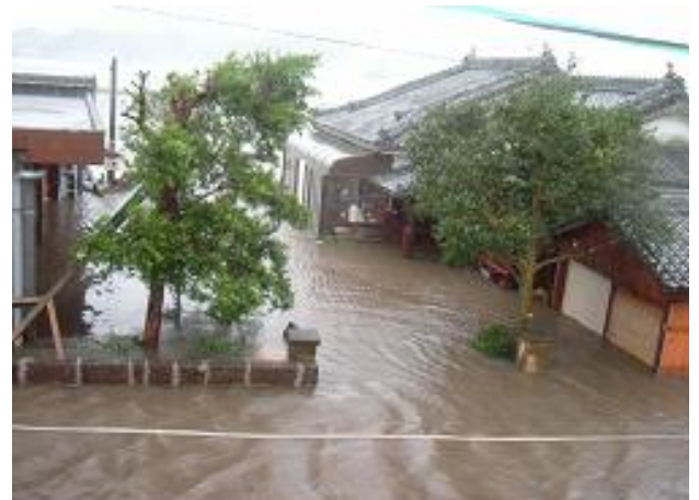
写真 1.2.13 肝属川左岸 10/000 付近 堤内地浸水状況
