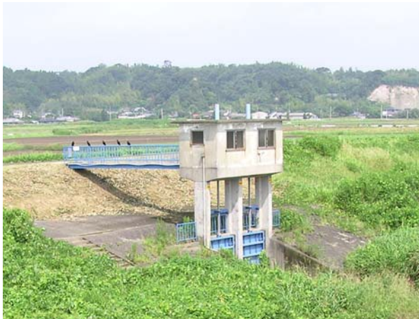
写真 2.1.10 樋管 (中郷第3 樋管：支川串良川)
