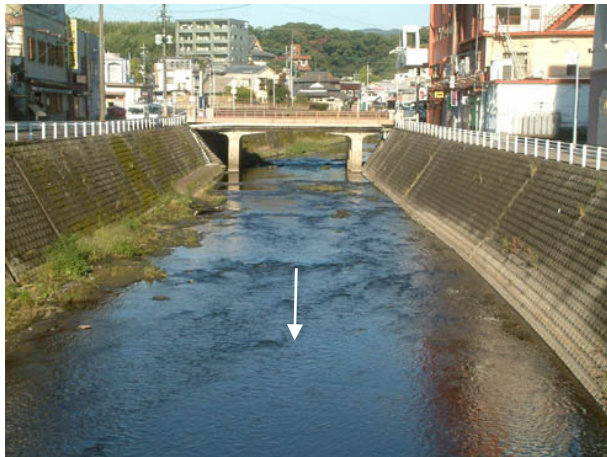
写真 2.2.7 鹿屋市街地中心部 (肝属川本川 18.4k 付近)
