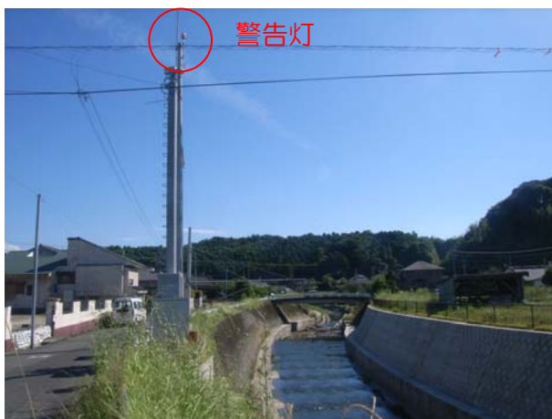
写真 4.3.12 川の警告灯（支川下谷川）
