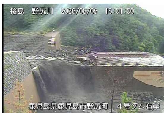
野尻川土石流の様子(8月6日)
