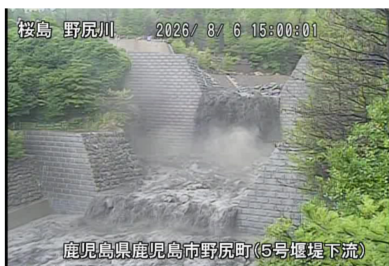
野尻川土石流の様子(8月6日)
