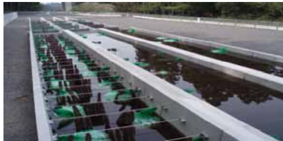
2号排水路浄化施設（鹿屋市）
