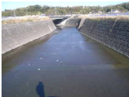
簡易な水質浄化施設 5号排水路（国土交通省）
