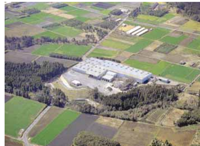
鹿屋市畜産環境センター全景写真
