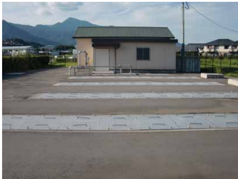
肝属川上流浄化施設
