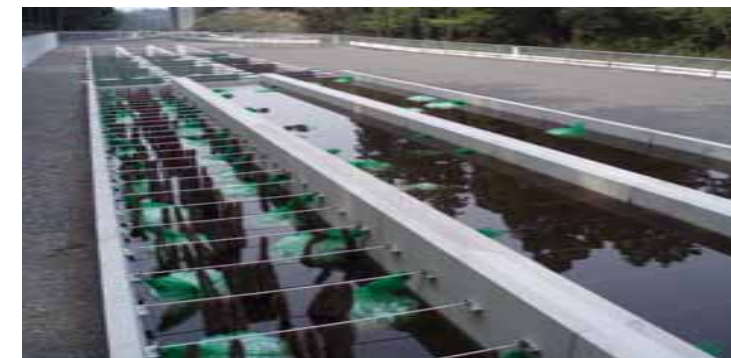
2号排水路浄化施設（鹿屋市）
