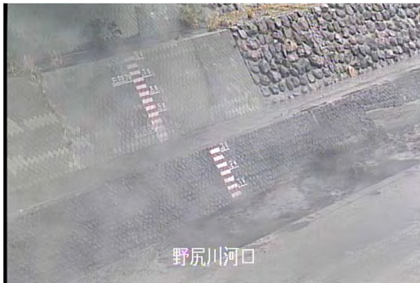
野尻川 土石流の様子(3月19日)
