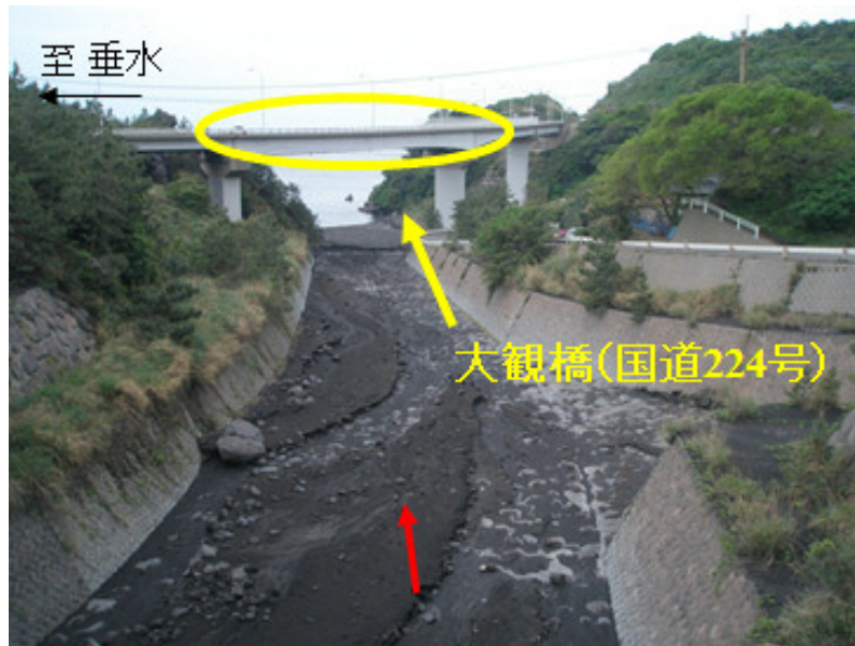
写真③ 第一有村橋から下流を望む（H27. 4. 9 11時00分撮影）
