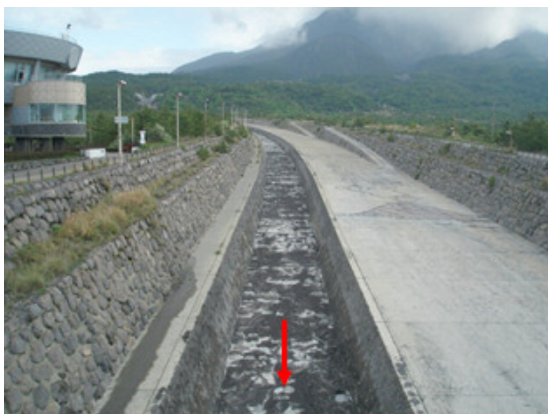
※顕著な土砂堆積は見られない。
